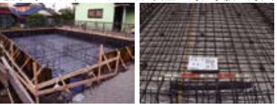
ベタ基礎はもちろん。配筋のピッチは150mmと強い基礎に仕上げております。
